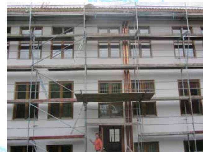
Der Altbau wird zum Neubau.
