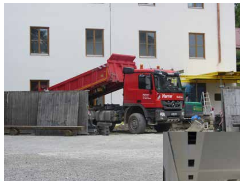
...das beliebteste Baufahrzeug...
