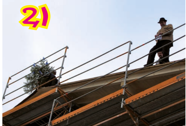
Das Richtfest vom neuen Gebäude.
