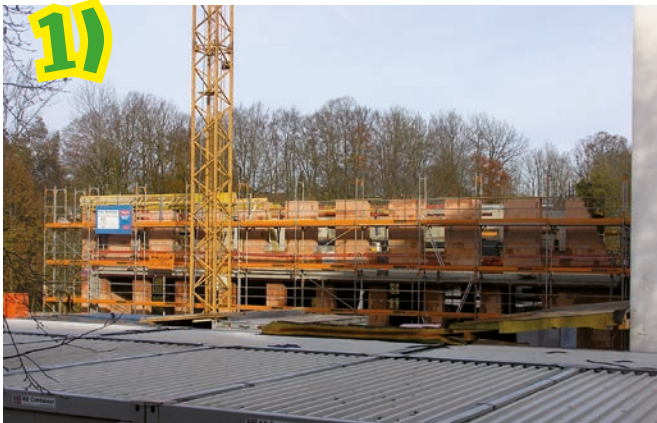
So fing es an. Der Rohbau der Schule.
